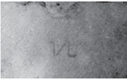
Absidiola del portacero pasquale. Particolare di un concio con un segno composto: due «L» contrapposte e separate da una diagonale.
