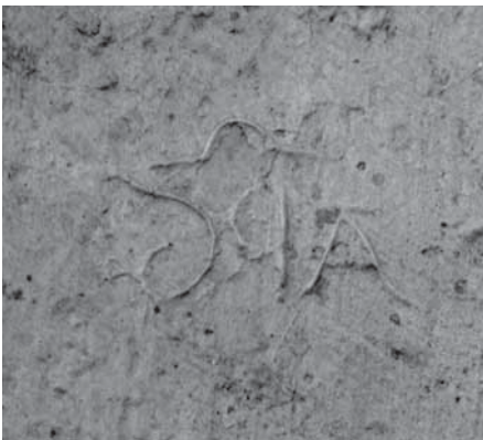
Simbolo e monogramma su un concio del semipilastro della parete a sinistra dell’attuale ingresso. Si noti una composizione di segni circolari: a destra una «P» a rovescio che ricorda i segni dell’archivoltio; una «A» con tratto posto al vertice superiore; a seguire un’altra «P» a rovescio. Sembra che sul concio siano stati riprodotti i segni di più maestri lapicidi.
